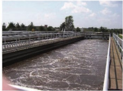
บ่อบำบัดน้ำเสีย
